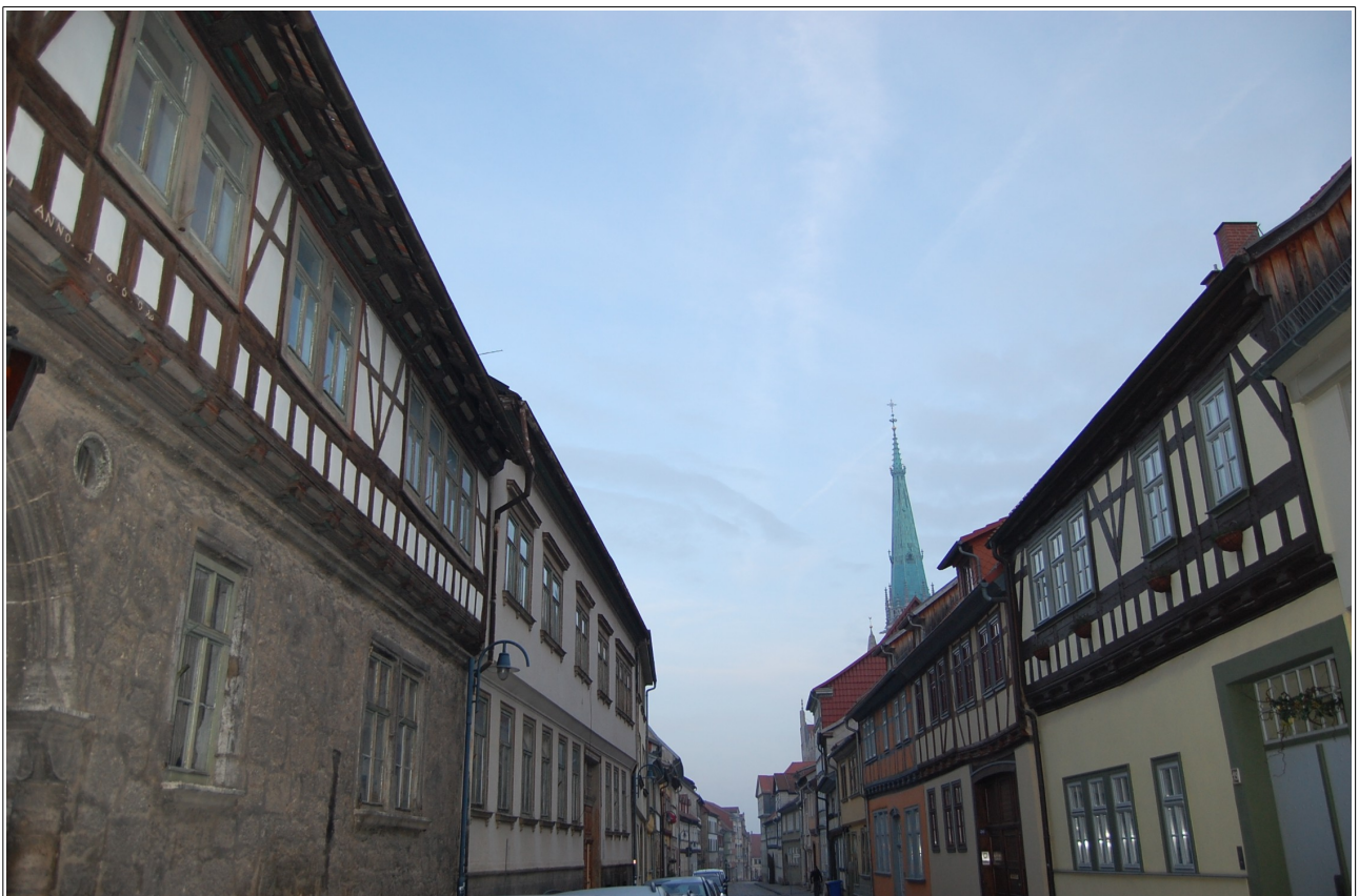
Mühlhausen (Thüringen), Blick in die Holzstraße nach Osten. Wiederaufbau nach dem Brand von 1649. Im Hintergrund der Turm der Marienkirche. Foto: Thomas Nitz, 2014.
